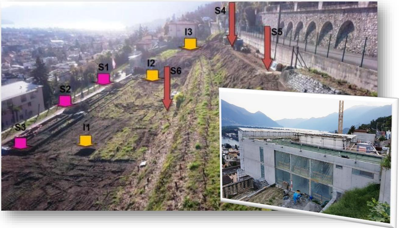
Fase iniziale del cantiere nel 2017 e posizioni prove geotecniche, fase finale del cantiere nel 2020.
