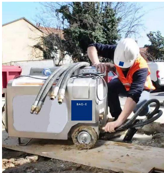
Fig. 1 Installazione attrezzatura GRT sul cantiere
