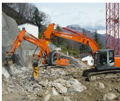
Scavo in roccia dura, inizialmente non previsto.
