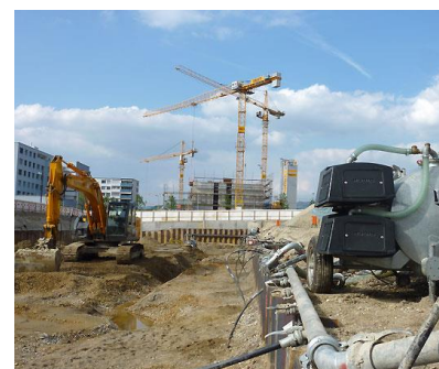
Falda acquifera deve essere gestita tramite sistema wellpoint.
