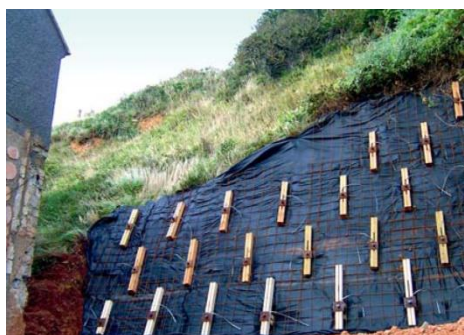
Ancoraggi temporanei per evitare dei cedimenti imprevisti.
